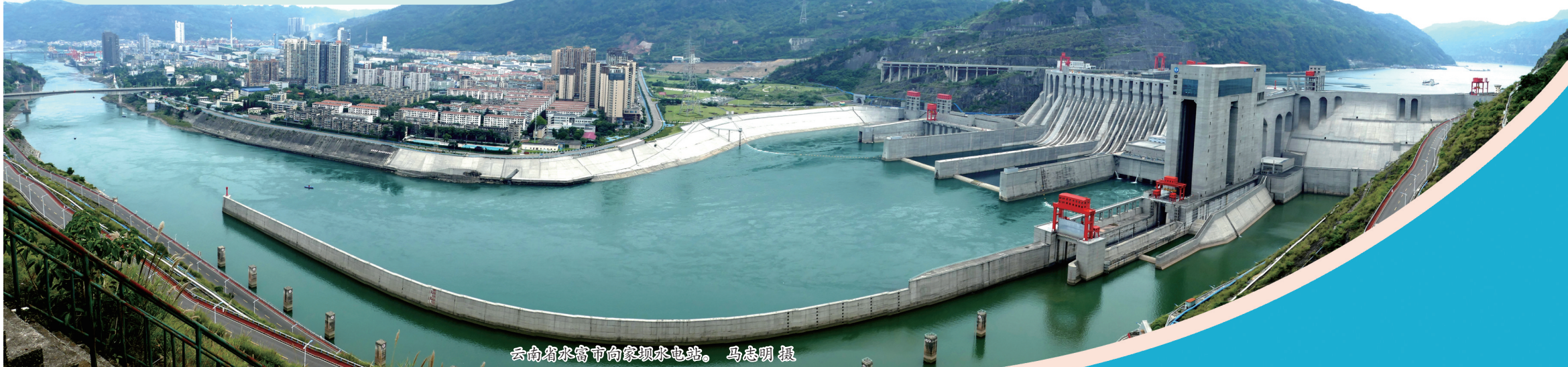
云南省水富市向家坝水电站。 马志明 摄
