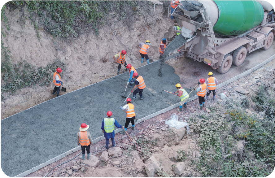
项目施工现场。
