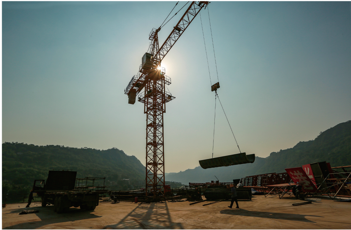
中嘴作业区塔吊。
