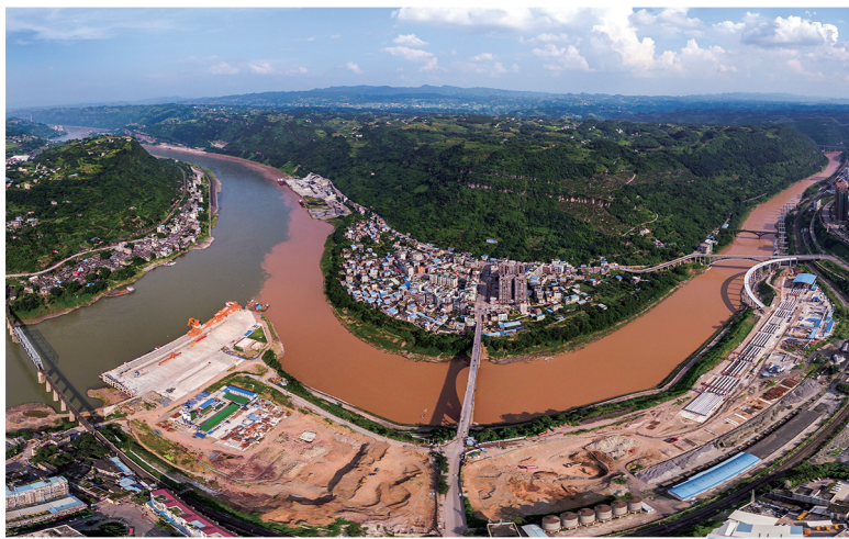
2019年,建设中的水富港全景。
