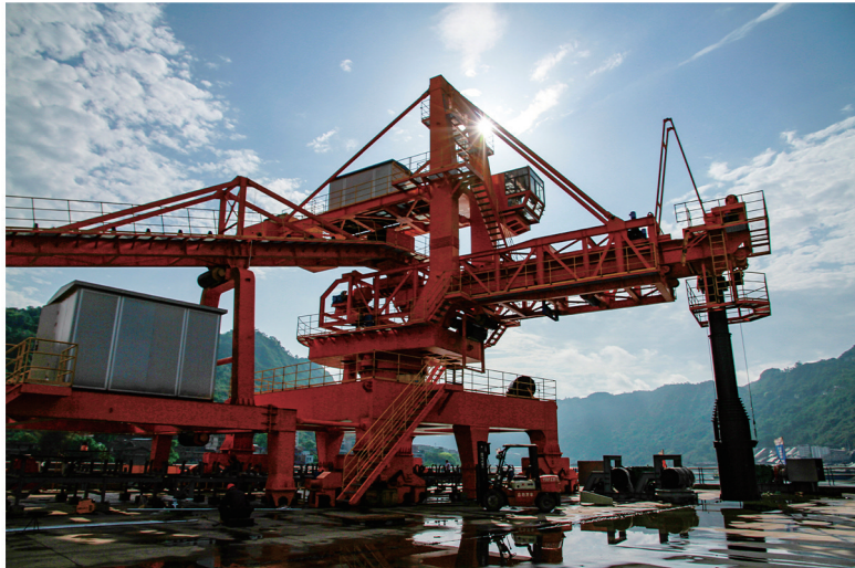
中嘴作业区安装港机。
