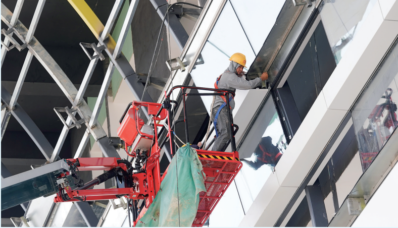
8月17日,工人在昭阳区境内的昭通东站施工。
