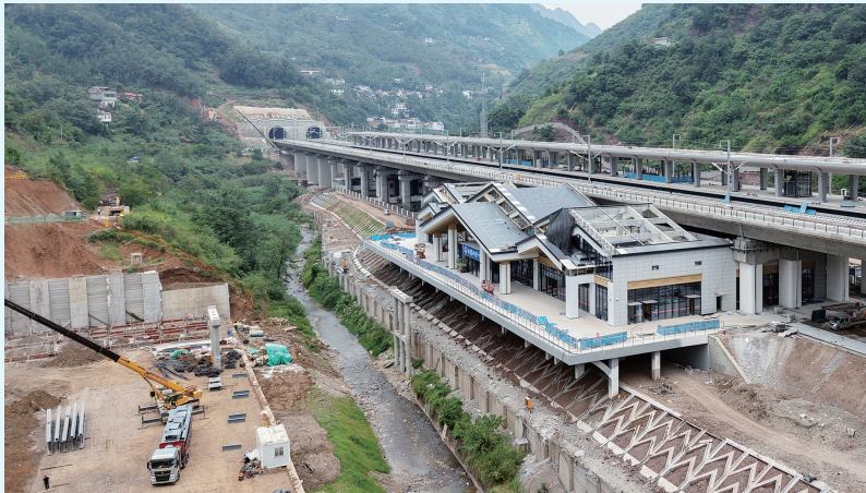
8月17日在云南省昭通市彝良县拍摄的正在建设的彝良北站(无人机照片)。
