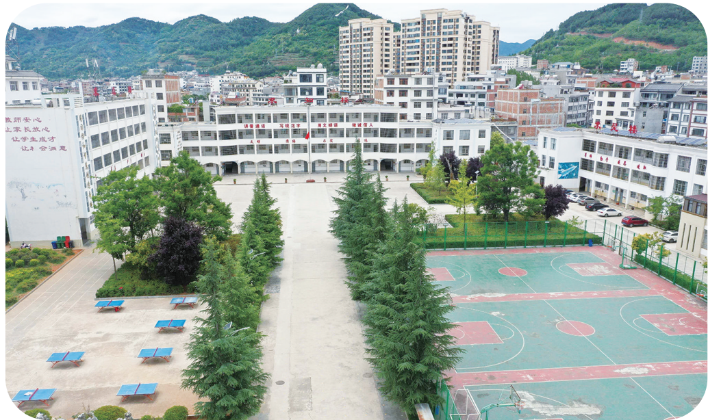
鲁甸县第三小学全景。
