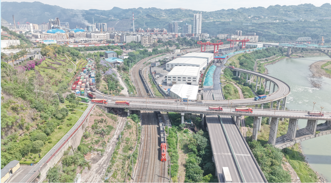
昭通市水富港“铁公水”多式联运枢纽片区。
