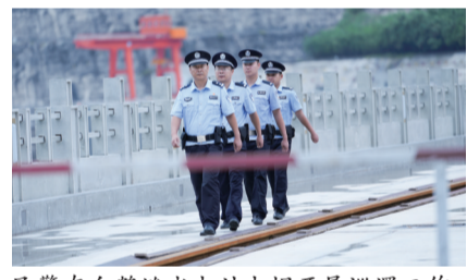
民警在白鹤滩水电站大坝开展巡逻工作。
