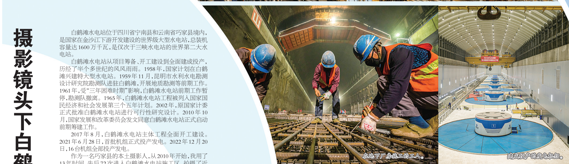
工人正在焊接坝体钢筋。
