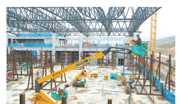
本报讯 (记者常开俊、安德立、张广玉)12月4日下午,渝昆高铁昭通东站屋面钢桁架完成现场拼装及整体提升就位,这标志着渝昆高铁昭通东站施工取得阶段性进展。
