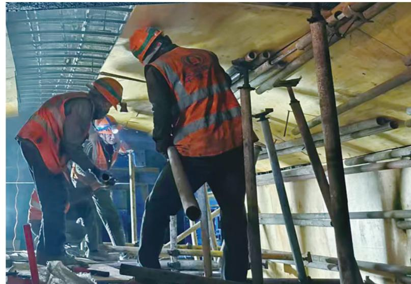
完成隧洞扩挖及支护工作。通过动态优化支护参数,实施“一米一策”的精细化管理,最终实现零安全事故、零质量隐患,成功解决浅埋软弱围岩条
