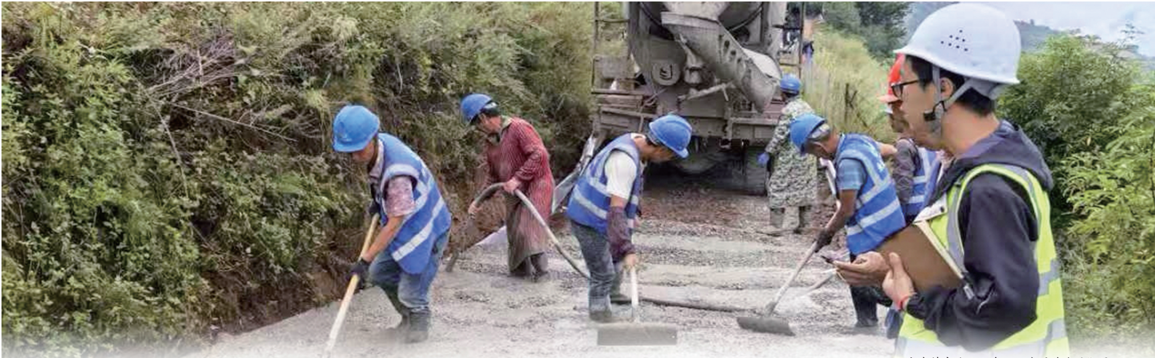
大寨镇实施2025年以工代赈道路硬化项目。
