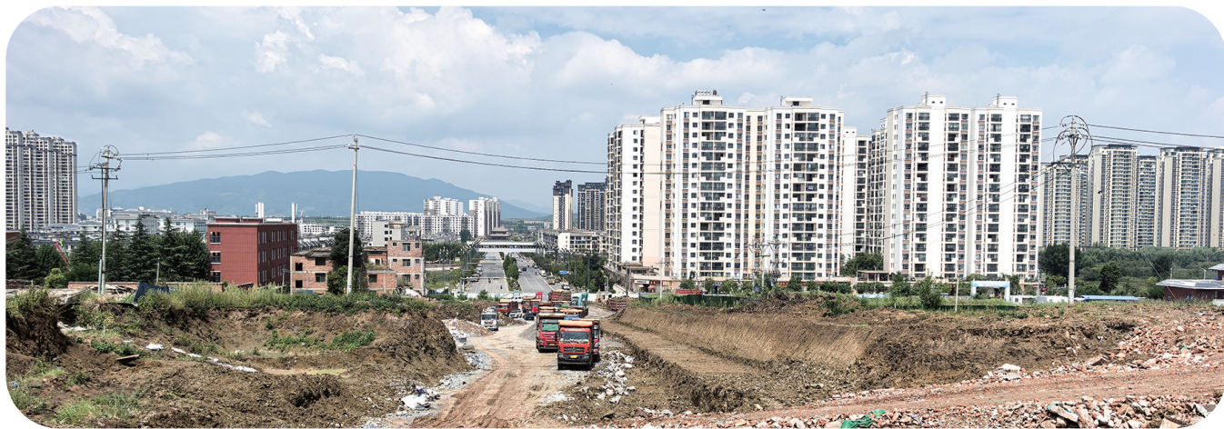
昭阳区全力加快失地农民安置房建设。
