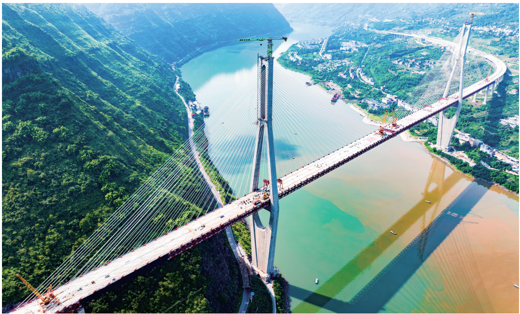
合龙后的新市金沙江特大桥。
