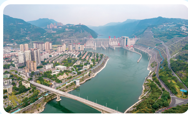
航拍向家坝水电站及水富市区。新华社记者 陈欣波 摄
