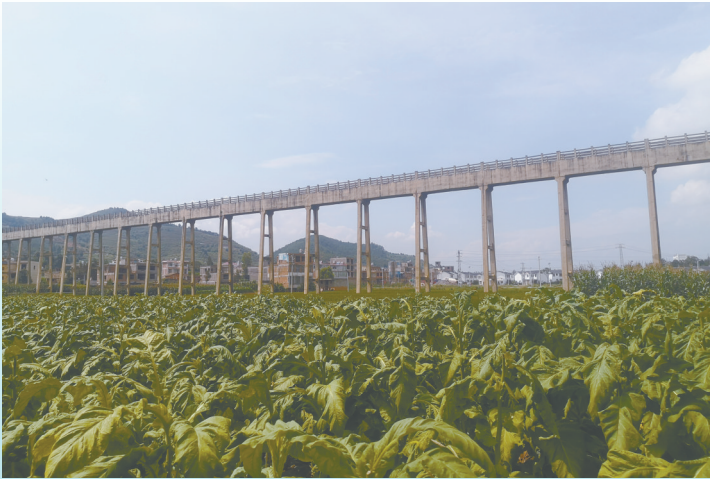
渔洞水库南干渠永丰镇马鞍山渡槽。
