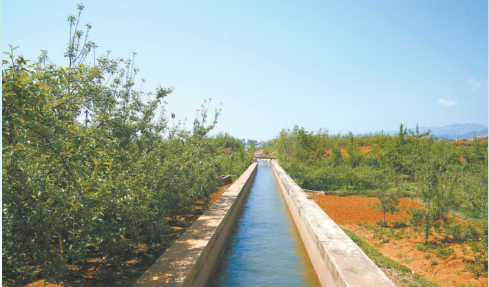
渔洞水库南干渠苏家院镇雷家冲段。
