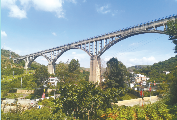
渔洞水库北干渠葡萄井渡槽。
