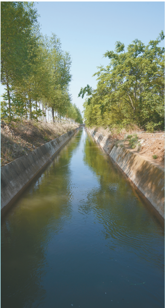
苏家院镇迤那村孔家营段引水渠。
