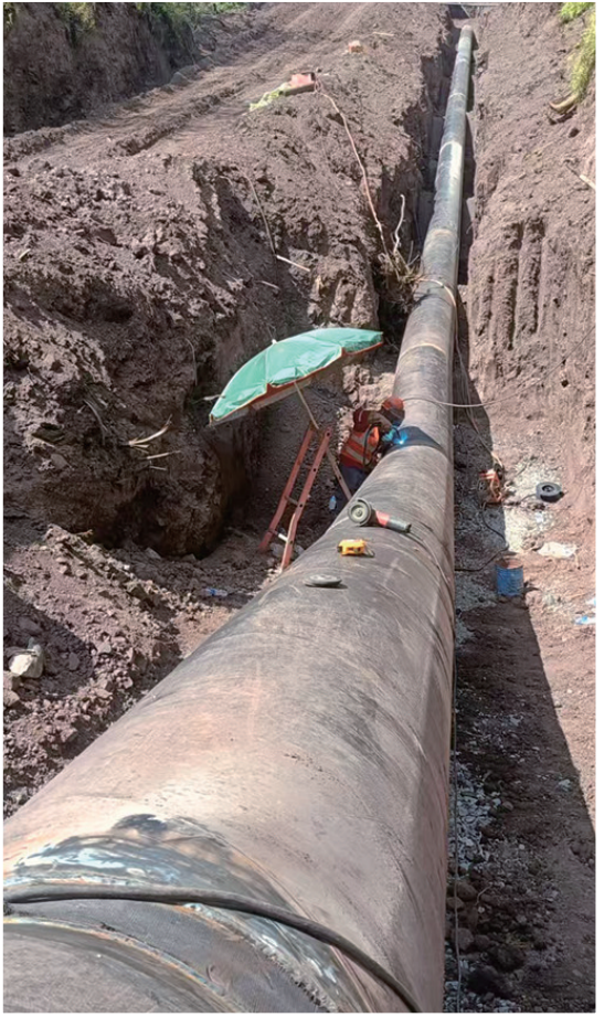
建设中的引渭灌溉工程。
