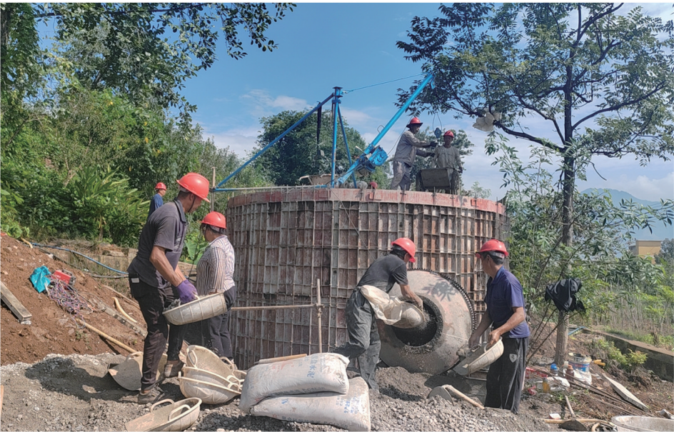
以工代赈蓄水池修建现场。
