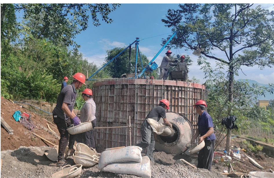
以工代赈蓄水池修建现场。
