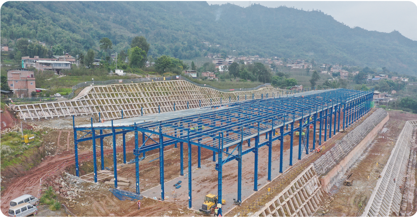
和平产业园区厂房建设正在加速推进。
