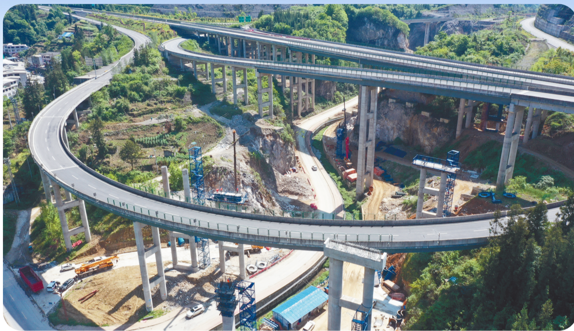
连接威彝高速公路与宜毕高速公路的马鞍山互通式立交。
