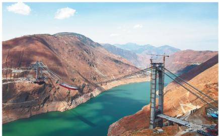
目前,由四路桥华东建设有限责任公司承建的G4216线沿江高速公路金沙江特大桥钢桁梁架设工作全面展开。川滇金沙江特大桥全长1140米,主桥为1060米单跨双塔钢桁梁悬索桥,位于白鹤滩水电站库区,连接四川省宁南县与云南省巧家县,是沿江高速公路巧家支线跨越金沙江、连接滇川两省的重要控制性工程。大桥预计2025年通车,建成后助力川滇两省经济交流,助力大小凉山、乌蒙山区乡村振兴。图片为在建的川滇金沙江特大桥(3月26日无人机拍摄)。
