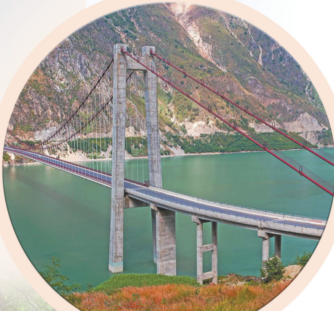
永善县跨金沙江的月亮湾大桥。
