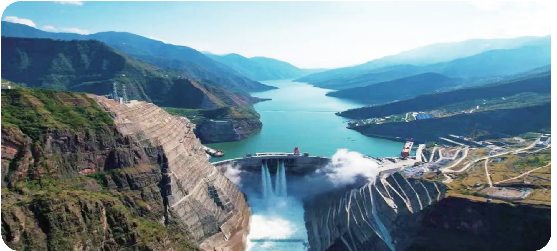
白鹤滩水电站。
