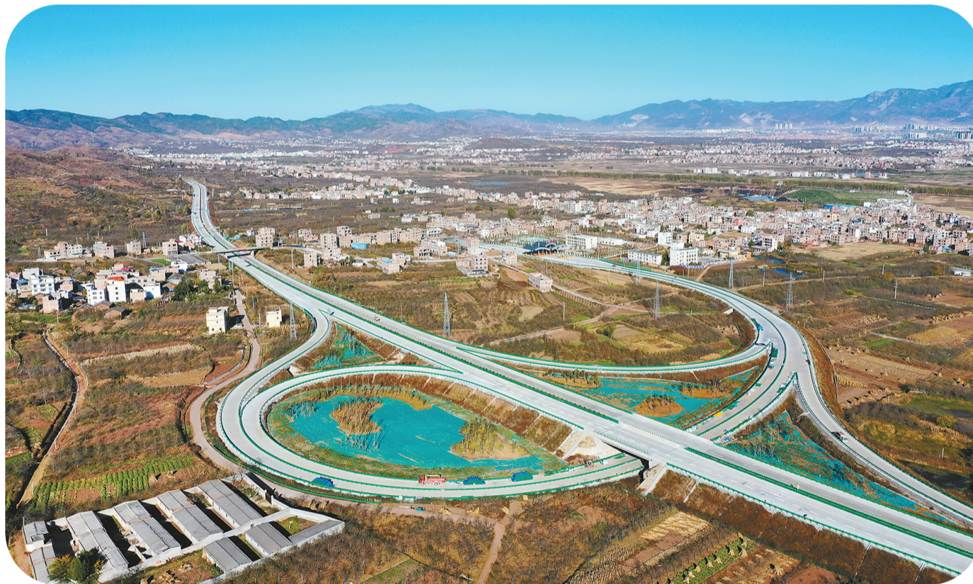
宏伟壮观的西环高速公路三善堂互通。
