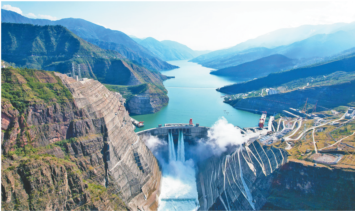
气势磅礴的白鹤滩水电站。
