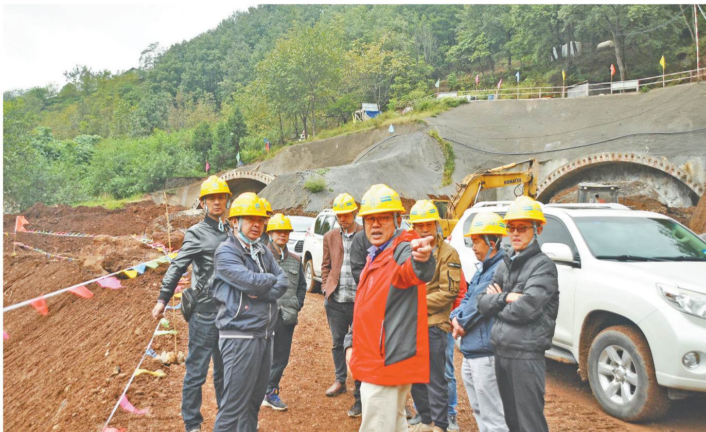
技术人员现场攻坚。
