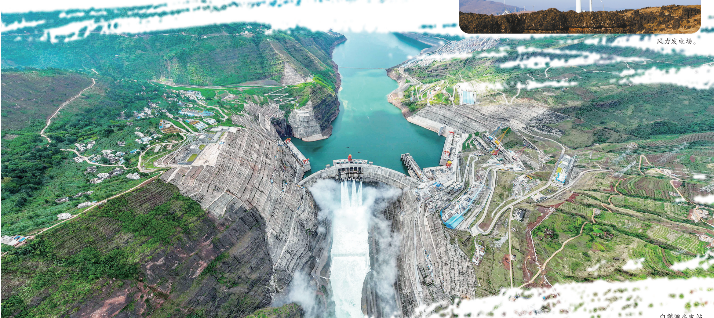
白鹤滩水电站。
