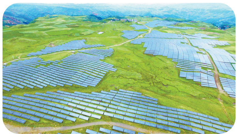
光伏发电基地。
